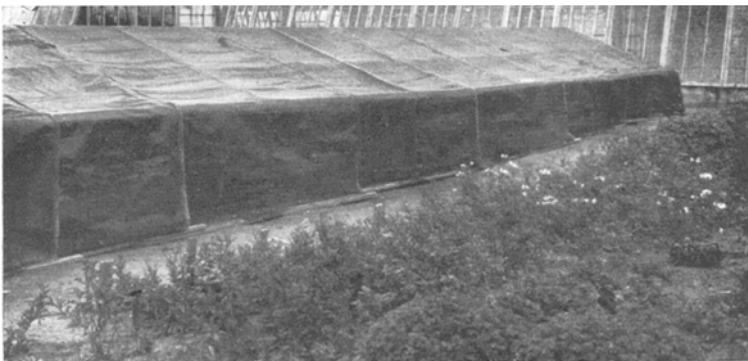
Abb. 2. Verdunkelung mittels Rollbahnen. Geschlossen.
